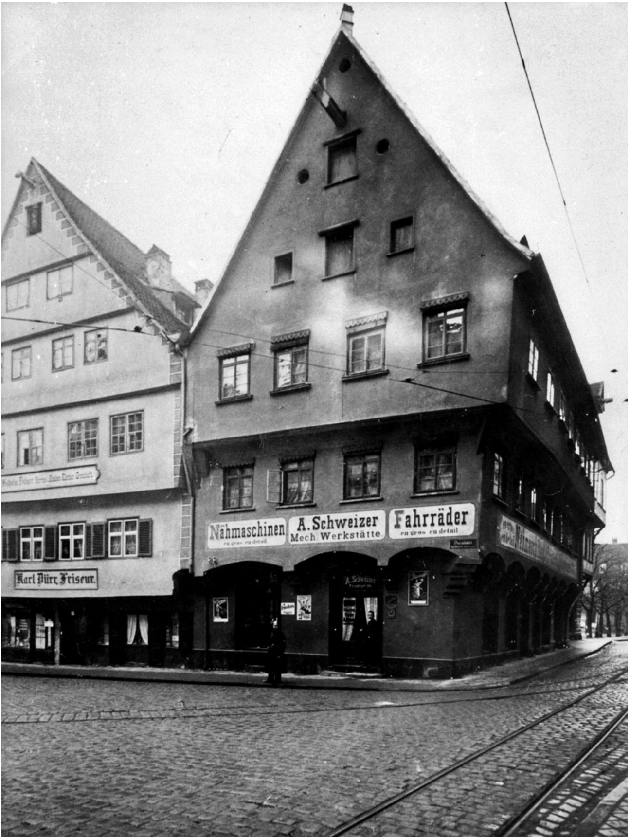
Abb. 84: Blick von der Langen Straße, Ecke Kramgasse nach Westsüdwest, Foto vor 1918. Gebäude von links: Marktplatz 2 (A 341, Friseur Dürr), Lange Straße 10 (A 186, Schweizer).
