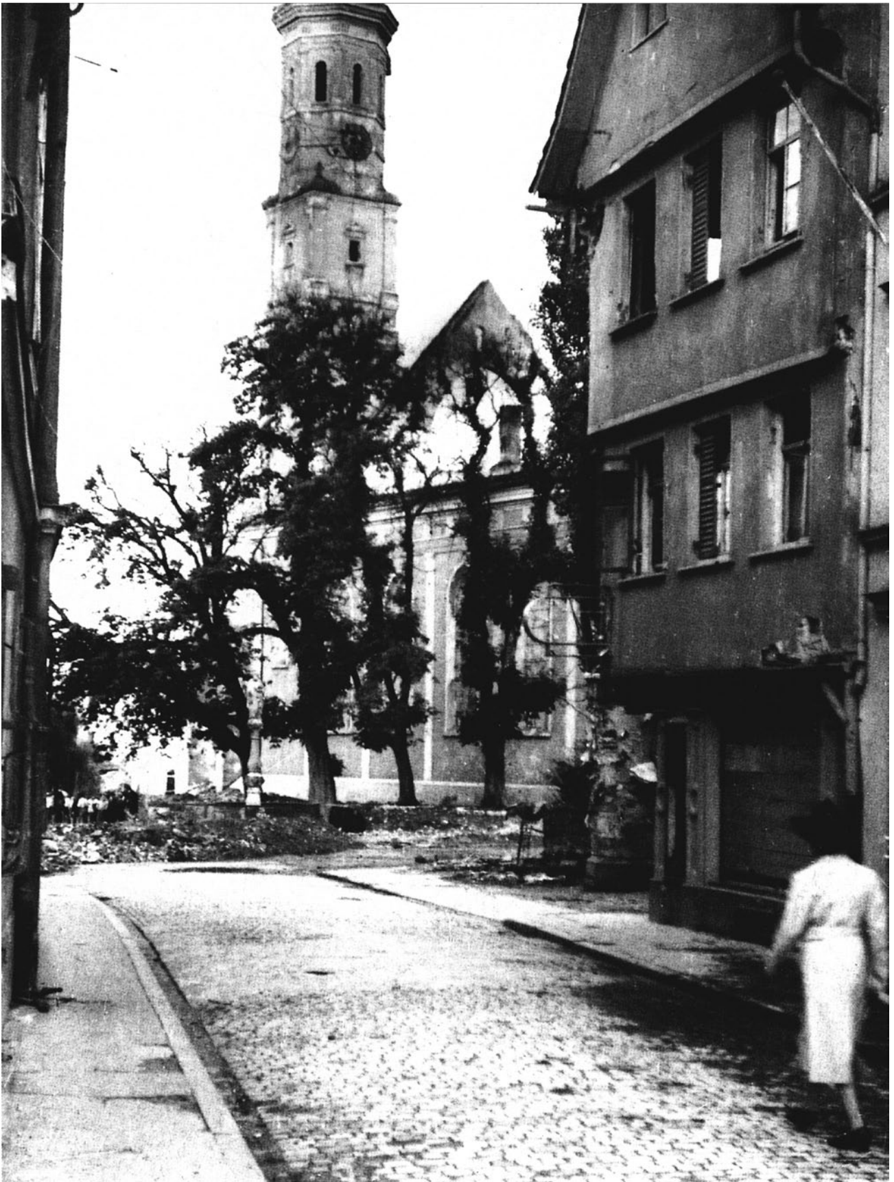
Abb. 112: Lange Straße beim „Gindele“ mit Dreifaltigkeitskirche, Haus in der Langen Straße (A 301), Foto nach 1945.
