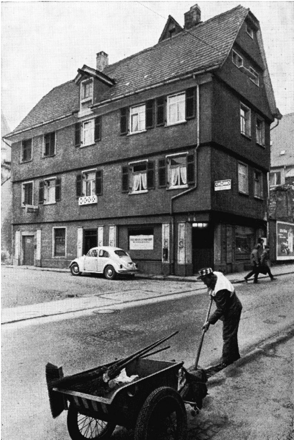
Abb. 113: Gebäude Lange Straße 34 (A 301), das verputzte Fachwerk, Foto um 1970.
