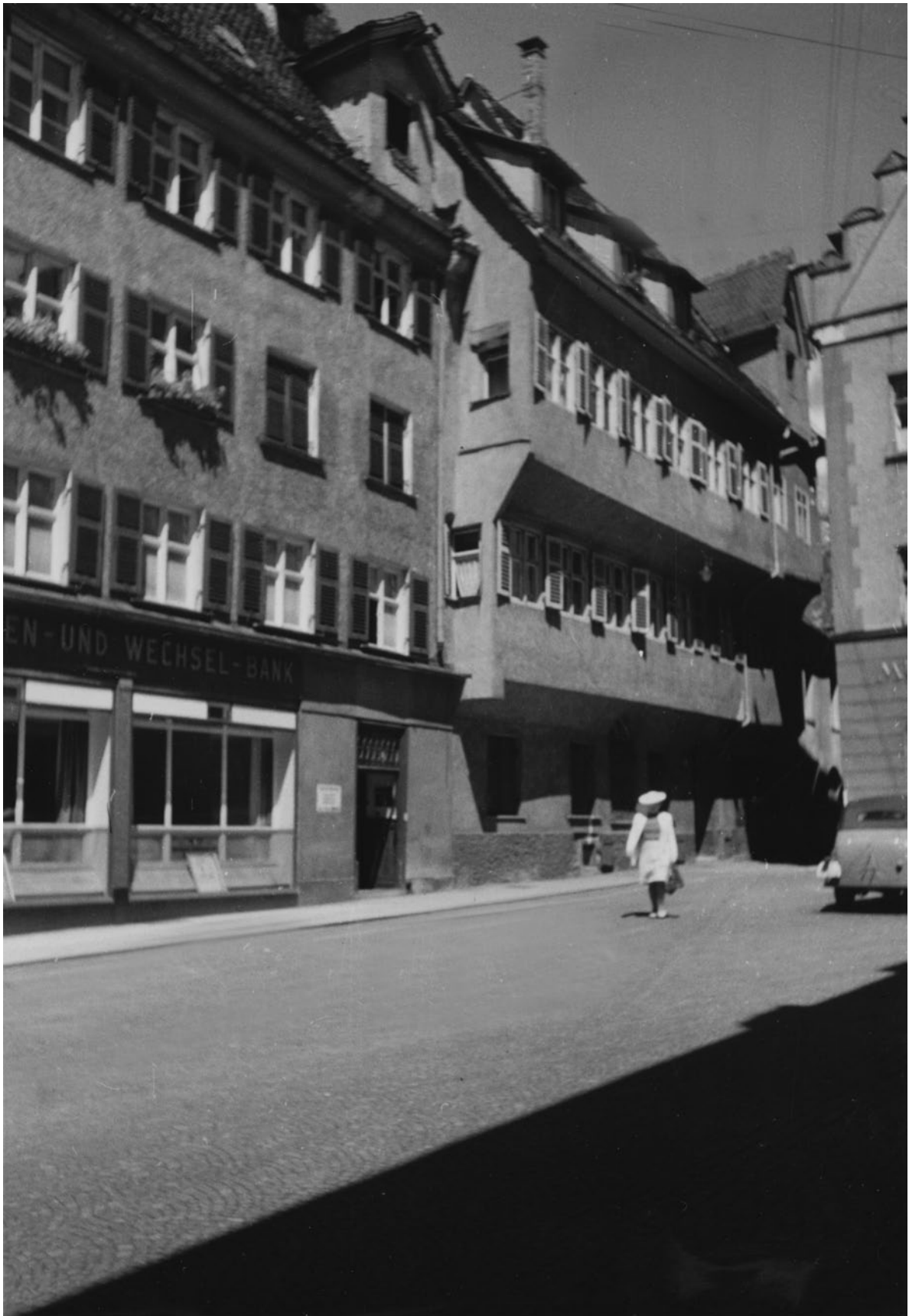
Abb. 118: Gebäude Taubengasse 1 (A 338), Gebäude rechts, Foto 1944.
