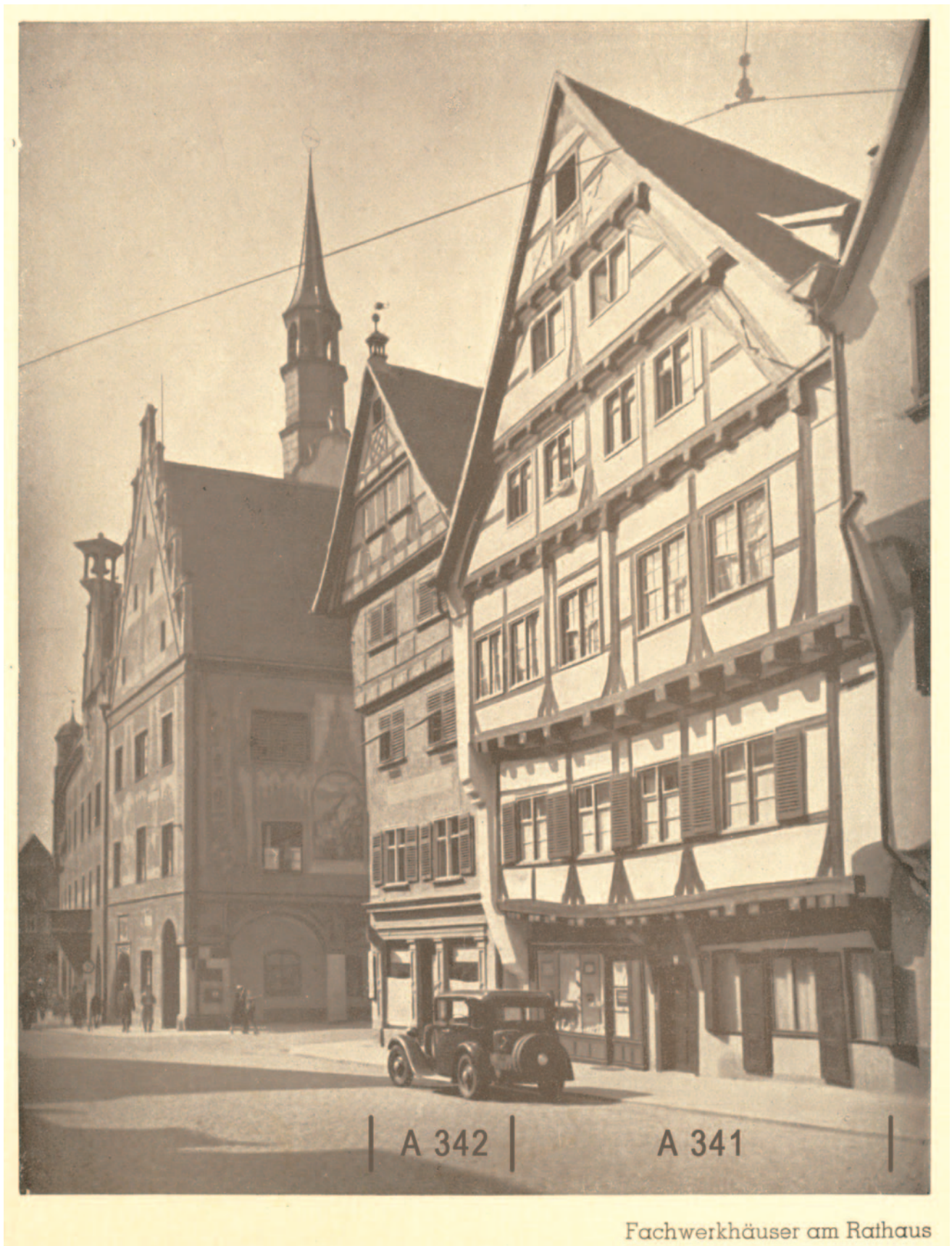
Abb. 130: Fachwerkhäuser am Rathaus, Foto um 1930.
