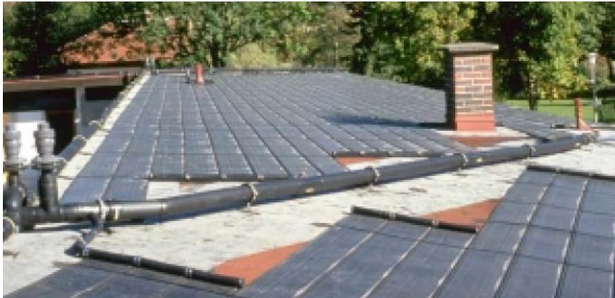
**Abb. 15:** Beispiel für die Installation von Thermosolkollektoren auf einem Flachdach<sup>8</sup>
