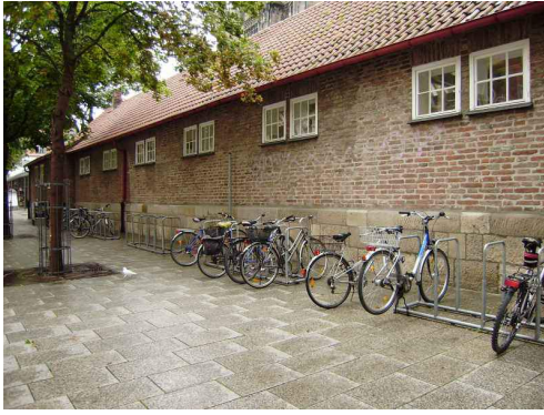
Abb. 21: Blick vom nördlichen Münsterplatz zur Münsterbauhütte seitlich des Münsters (Quelle: Melanie Keding)
