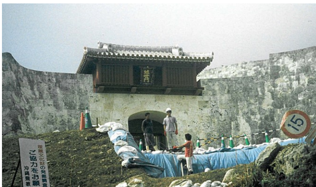
Abb. 49: Foto der Bauarbeiten am Keiseimon
