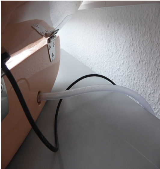
Abbildung 13: Abflussschlauch für Leckage
