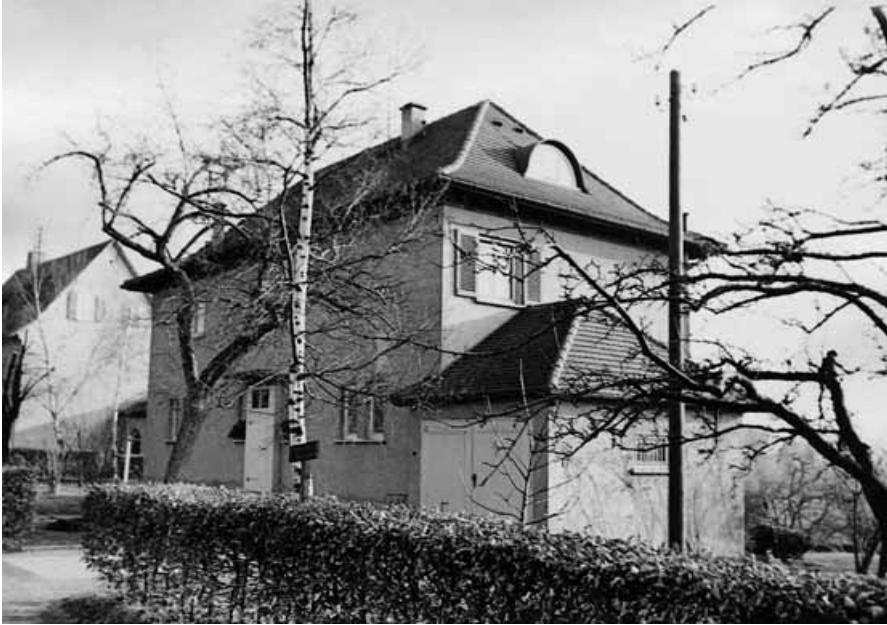
Wohnhaus Reutlingen, Raabestraße 25. Es wurde 1937 von Eugenie und Lore Arnold erbaut.
