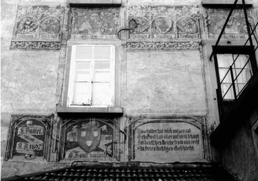
Abb. 6: Zwiefalterhofstraße 2, Fassadenausschnitt mit Teilen des Wandbildes, Zustand Anfang 1970er Jahre. Das kürzere bemalte Band unter dem linken Fenster des 1. Obergeschosses enthielt in einem der drei Felder das Entstehungsdatum und den Namen des Künstlers.
