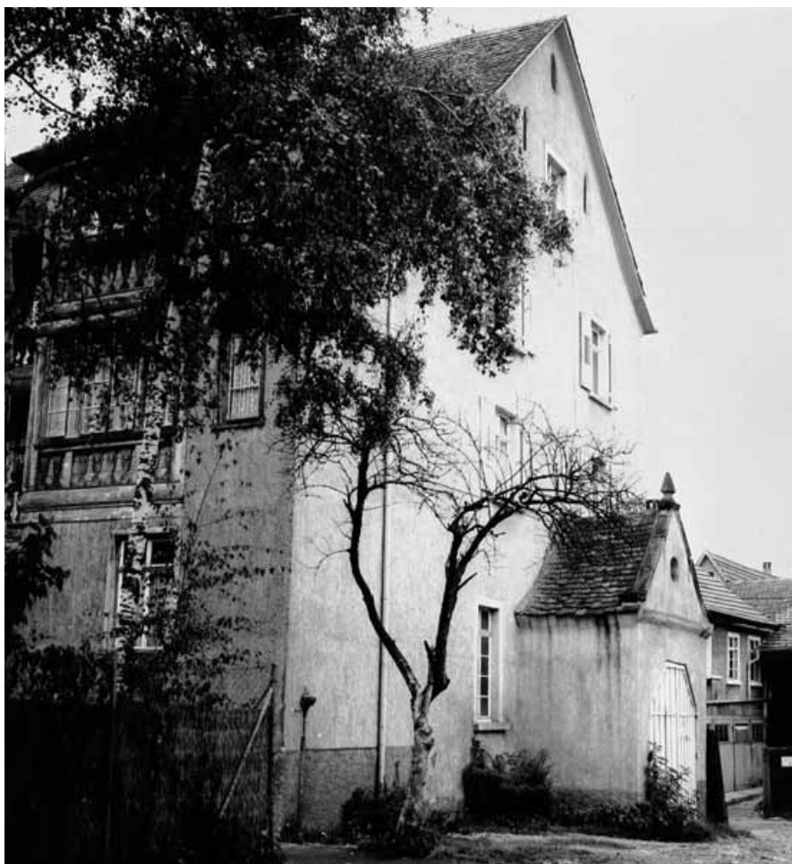
Abb. 11: Anbau für die Kellerhalstreppe in der Mitte des Nordostgiebels von Zwiefalterhofstraße 2, Anfang 1970er Jahre.
