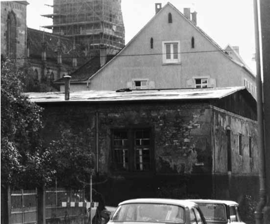
Abb. 1: Zwiefalter Hof von der Gartenstraße aus, 1974. Vorne das nach dem Krieg nur mit einem Notdach provisorisch geschützte Erdgeschoss des Gebäudes Zwiefalterhofstraße 4, darüber die nordöstliche Giebelscheibe des Gebäudes Zwiefalterhofstraße 2 mit den drei fast schwarzen „Schlitzen“ im Giebeldreieck.
