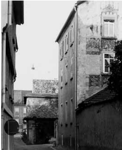
Abb. 10: Das Gebäude Zwiefalterhofstraße 2 von der Metzgerstraße aus, 1974. Die beiden niedrigen Fenster im Sockel gehören zu dem Gewölbekeller des Gebäudes.
