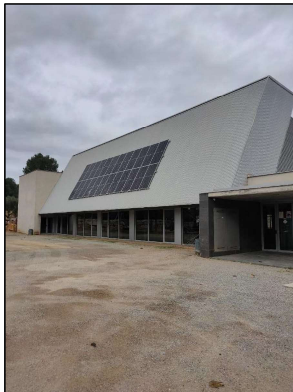
Abbildung 4: Photovoltaik-Anlage auf dem Gemeindezentrum in Rupia, Girona (Eigene Aufnahme).
