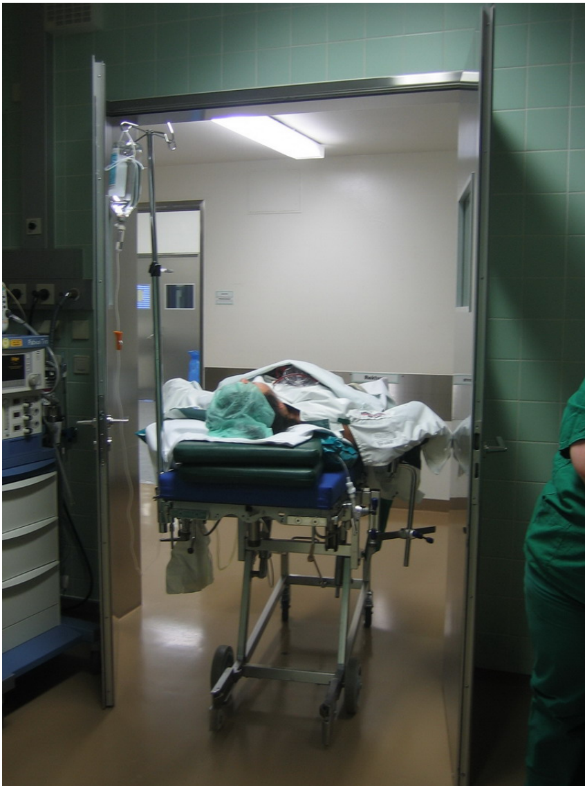
Abbildung 29: Die Drehtüren erschweren das Verschieben der Patienten und haben einen erhöhten Platzbedarf. Durch die Verwendung von Schiebetüren könnten diese Probleme behoben werden.
