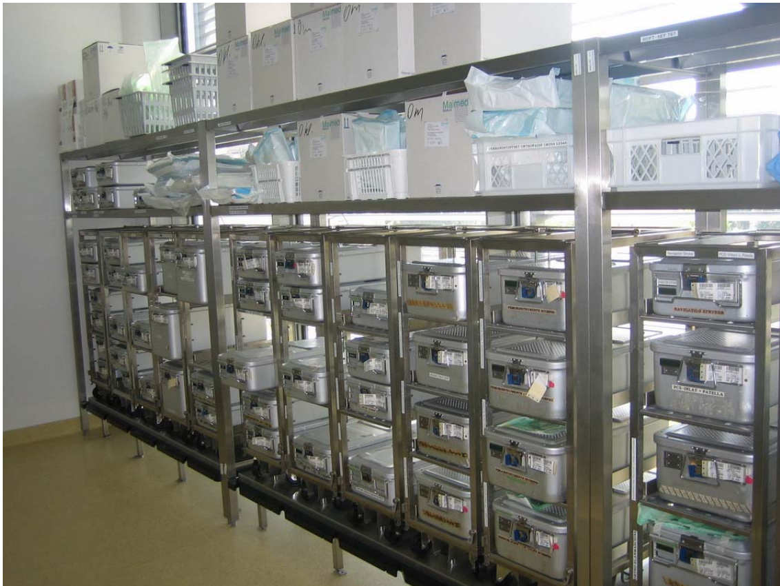
Abbildung 50: Die Fensterfront des Raumes, der eigentlich als Personalaufenthaltsraum geplant war, ist nun durch Regale verstellt.
