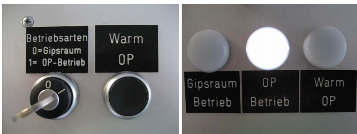
Abbildung 16: OP 7 verfügt über ein umschaltbares Belüftungssystem. Eine Leuchte auf dem Bedienfeld zeigt an, in welchem Modus sich das System momentan befindet.
