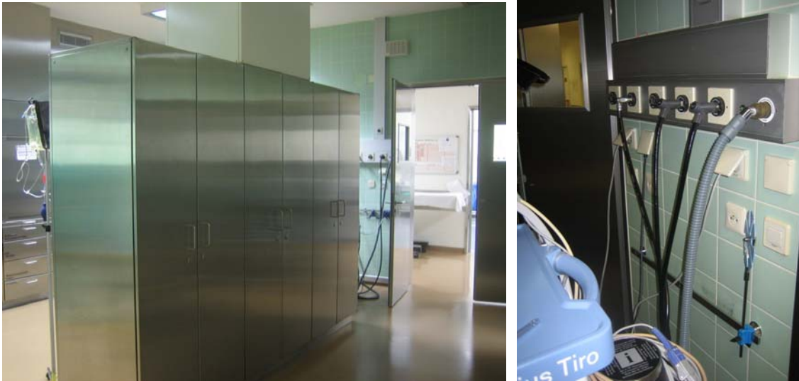
Abbildung 30: Zwischen Schrankwand und Decke könnten problemlos Glasscheiben eingebaut werden. Für den Einbau einer Glasscheibe zwischen Wand und Schrankwand müsste eine neue Lösung für die Anschlüsse, die sich bisher dort befinden, gefunden werden.
