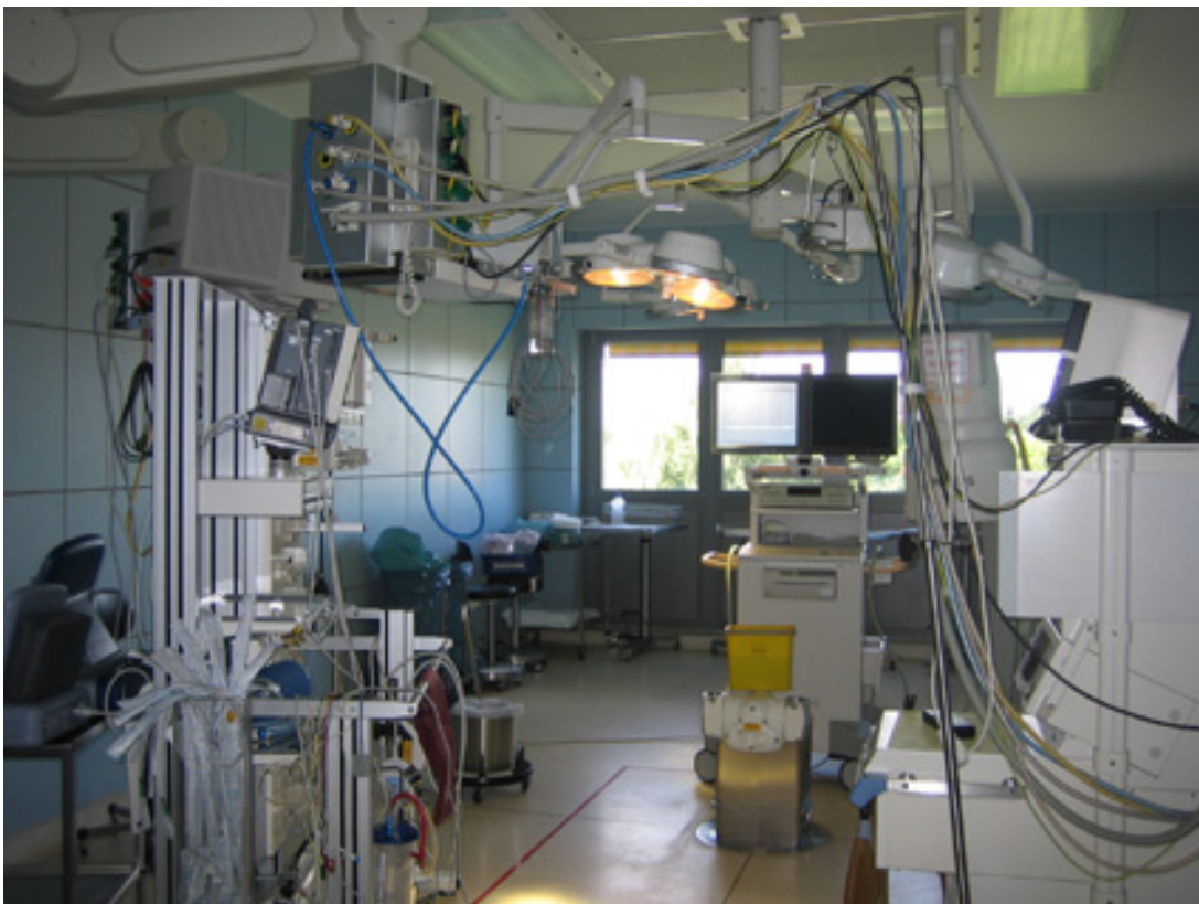
Abbildung 13: In OP 4 zieht sich ein Strang von Kabeln und Schläuchen von der DVE über einen Infusionsständer zum Narkose- und Beatmungsgerät auf der anderen Seite des Raumes.
