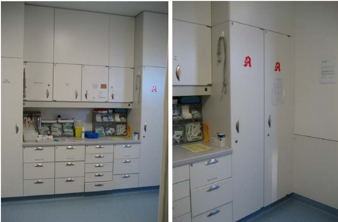
Abbildung 31: In der zentralen Einleitung ist genügend Platz vorhanden, um das Material und die Medikamente der Anästhesie zu lagern.
