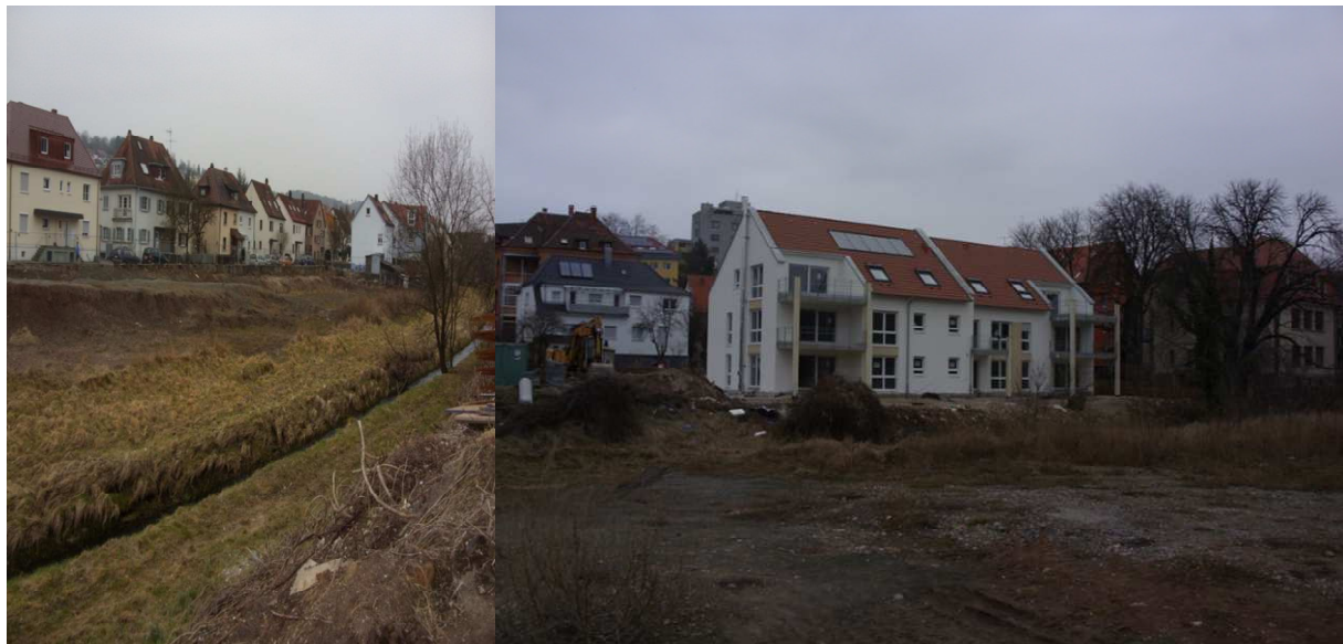
Abbildung 9: Ehemaliges Steinhilber Gelände
