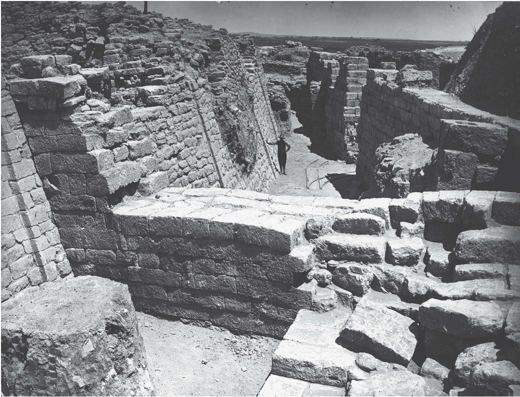
Abb. 8 Die Troia VI-Burgmauer und Turm VIh nach der Ausgrabung 1894 (DAI Athen, 562)
