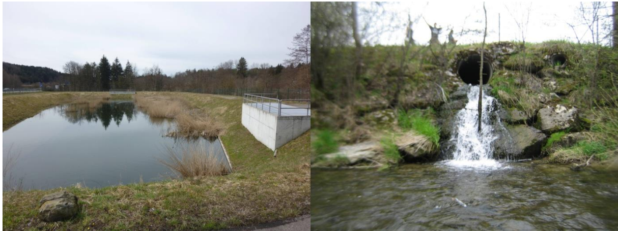
Abbildung 9: RKB Dürren an der A96, Anschlussstelle Wangen-Nord bei Dürren (links); Auslauf des RKB Dürren (rechts)
