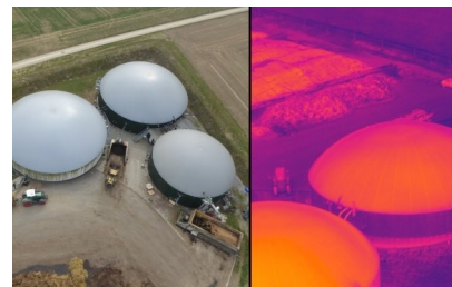
(b) Inspektion einer Biogasanlage mit Farb- und Thermalkamera (Quelle: ©AirRobot)
