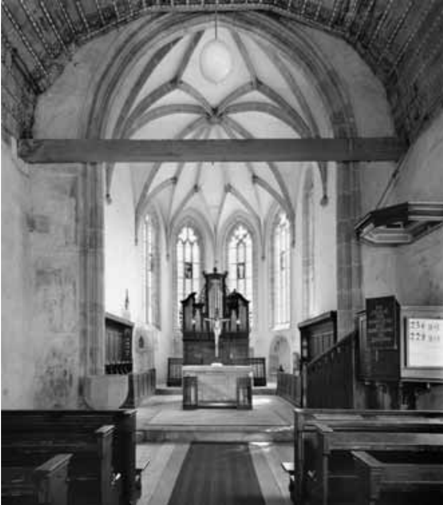
Abb. 14: Marienkirche Bronnweiler, Blick aus dem Schiff in den Chor, Chorbogen mit ursprünglicher Aufstellung von Kanzel und Taufstein sowie verziertes Holztonnengewölbe (Aufnahme vor 1968).
