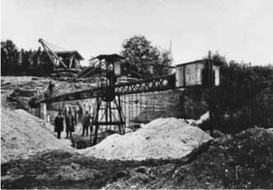
Abb. 5: Die Schrade'sche Felsensäge.
