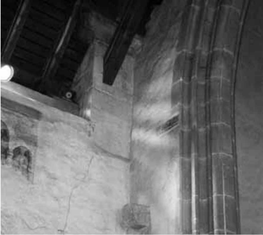
Abb. 13: Marienkirche Bronnweiler, Nordwand des Schiffs mit Turm und Chorbogenwand mit Kragstein als Auflager und Wandmalerei der Phase III (Aufnahme 2010).
